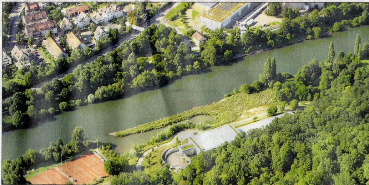
Ein Seitenarm am Neckar wurde im ersten Bauabschnitt erstellt. Nun soll ein Durchfluss zum Neckar gemacht werden und der Aushub auf die derzeit noch überwucherten Bereich der Altlasten (rechts) geschüttet werden. Foto: Bezold
