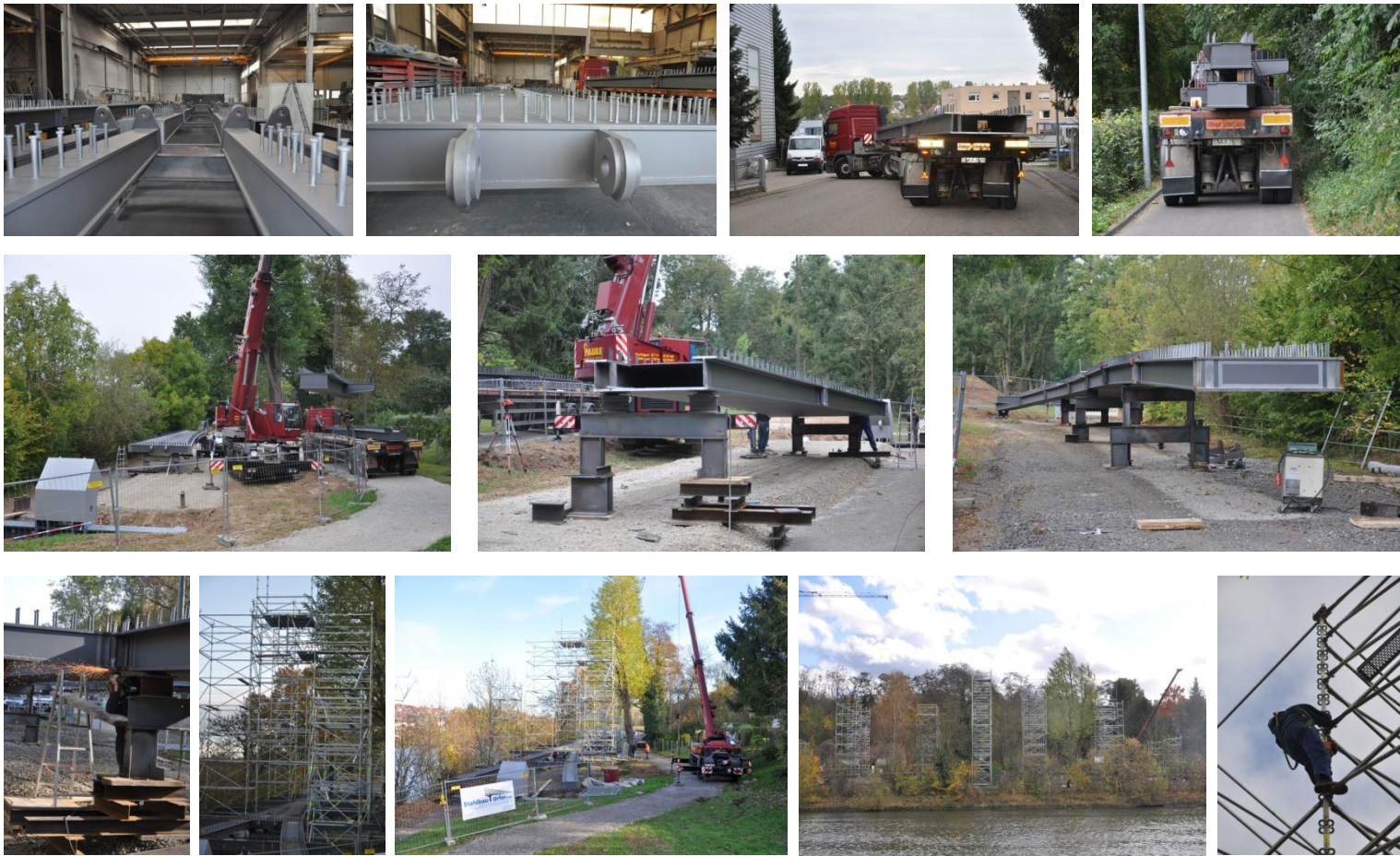
Die Bilder zeigen die Vormontage der Brückenteile bei der Fa. Urfer in Aldingen, den Transport der Brückenteile und die Endmontage auf der Hofener Neckarseite.
