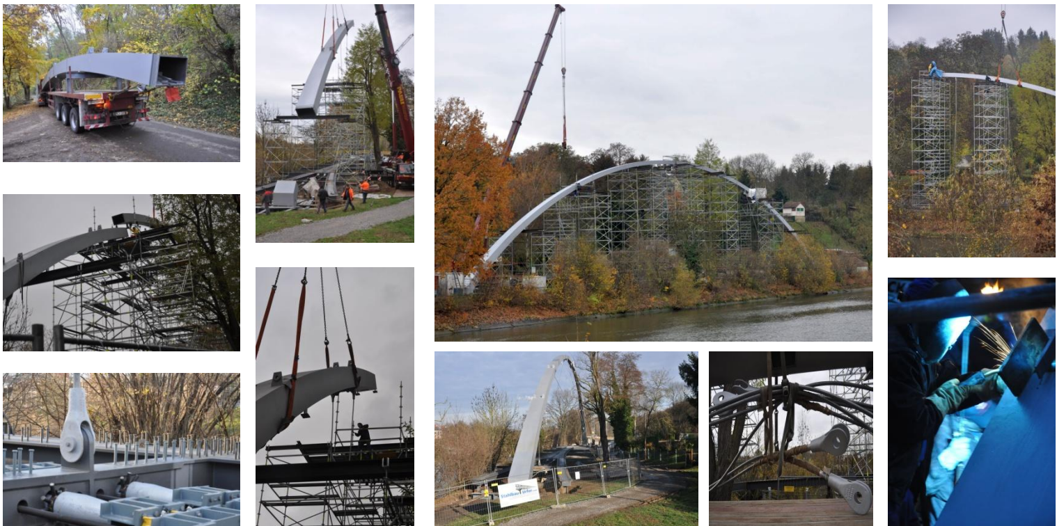
Die Bilder zeigen die Vormontage der Brückenteile bei der Fa. Urfer in Aldingen, den Transport der Brückenteile und die Endmontage auf der Hofener Neckarseite.
