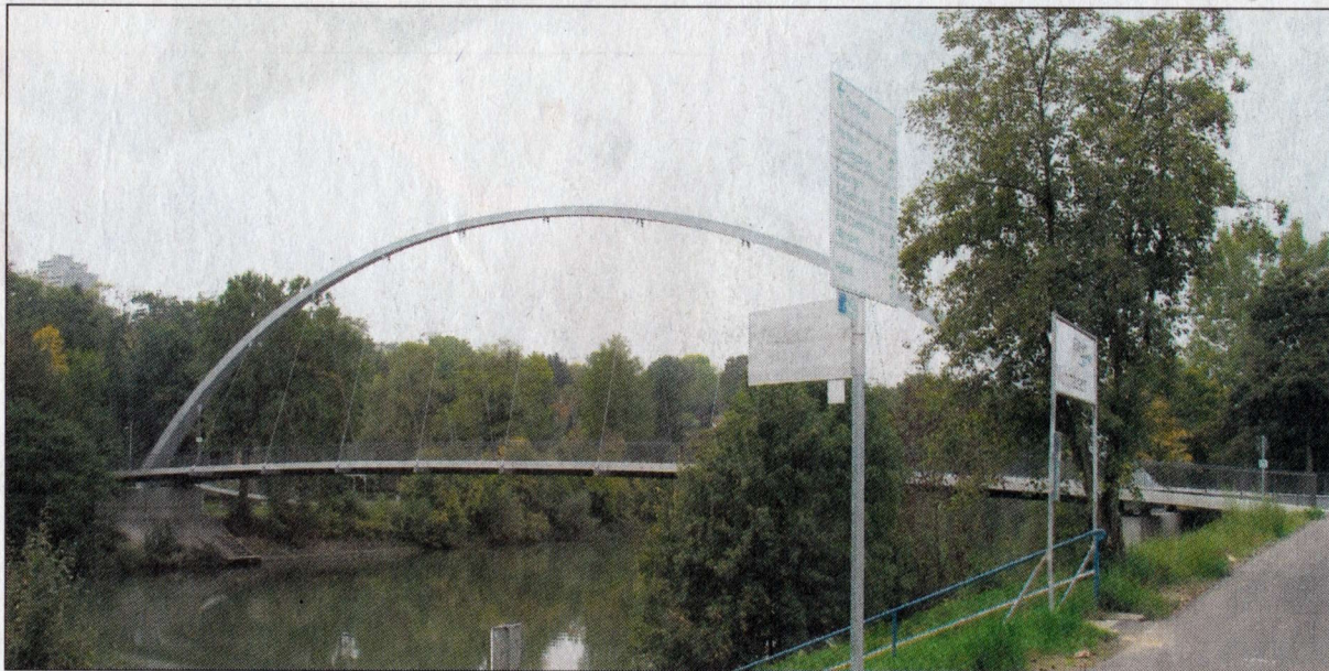
Die neue Brücke in Hofen soll den Namen „Vier-Burgen-Steg“ erhalten. Eine Jury hat darüber befunden und auch die Vorschläge von Bürgern aufgenommen. Foto: Frey
