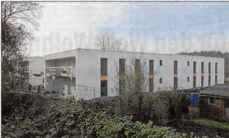
Die Flüchtlingsunterkünfte in Hofen werden derzeit noch gebaut. Anfang kommenden Jahres sollen die ersten Flüchtlinge einziehen. Foto: Frey
